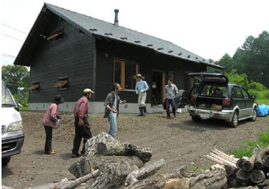
建設中の自宅、薪ストーブで使う薪も準備
